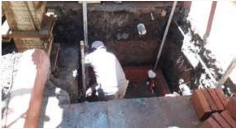
Excavación para tanque cisterna
