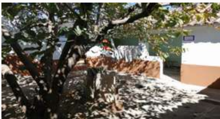
Revoque y pintura exterior
