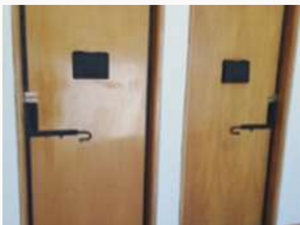
Refuerzo de puertas, visores y aldaba de seguridad
