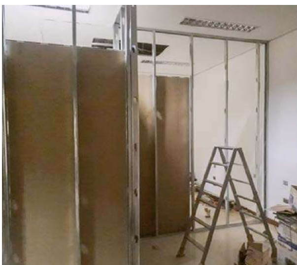
ÍTEM PROV. Y COLOCADO DE MURO DRYWALL 2 CARAS
