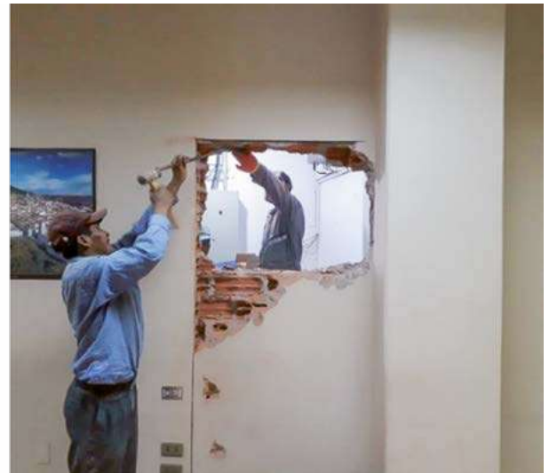
ÍTEM DEMOLICIÓN DE MURO DE LADRILLO E=20CM
