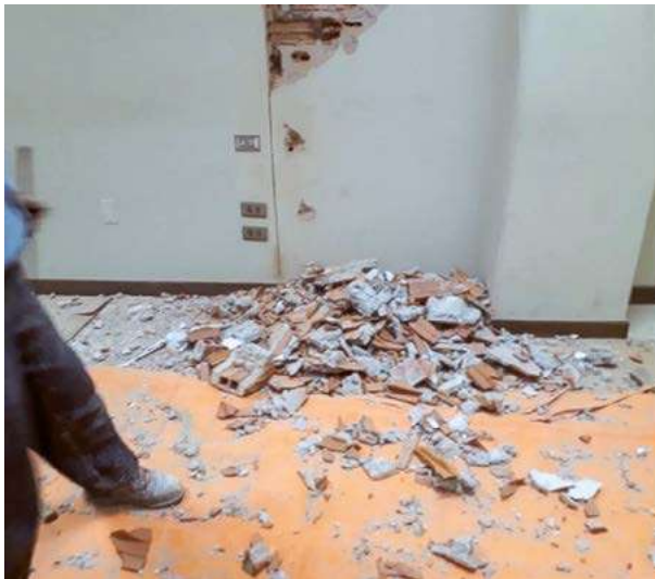
ÍTEM DEMOLICIÓN DE MURO DE LADRILLO E=20CM
