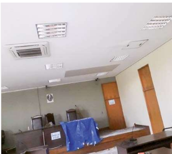
ITEM PROV. E INST. DE PLACAS DE YESO DURLOCK EN CIELO FALSO
