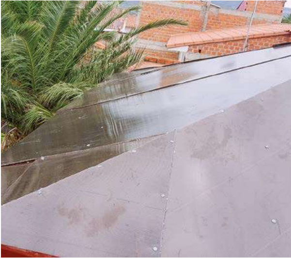
CAMBIO DE CUBIERTA DE POLICARBONATO
