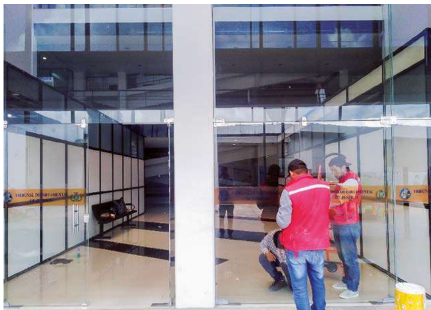
MANTENIMIENTO Y CAMBIO DE PIEZAS DE PUERTAS DE VIDRIO TEMPLADO
