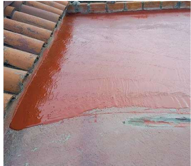
IMPERMEABILIZACIÓN DE LOSA
