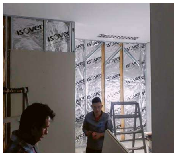
ÍTEM PROV. Y COLOCADO DE MURO DRYWALL 2 CARAS
