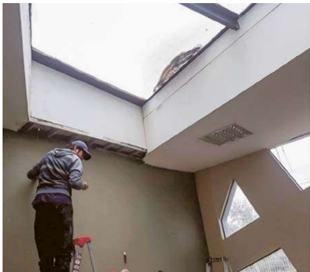
ÍTEM DEMOLICIÓN DE CIELO FALSO
