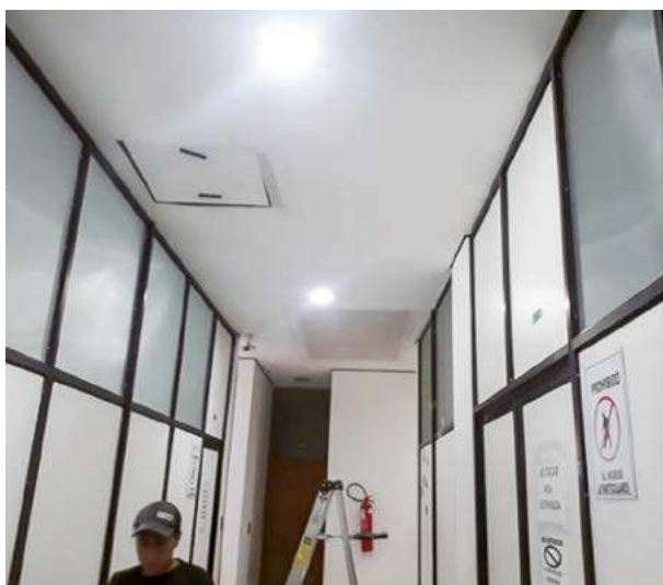
ITEM PROV. E INST. DE PLACAS DE YESO DURLOCK EN CIELO FALSO
