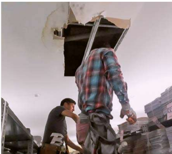
ÍTEM DEMOLICIÓN DE CIELO FALSO
