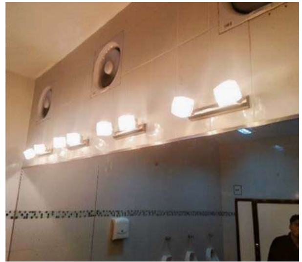
PROVISIÓN Y COLOCADO DE FOCOS DE APLIQUETS EN BAÑOS
