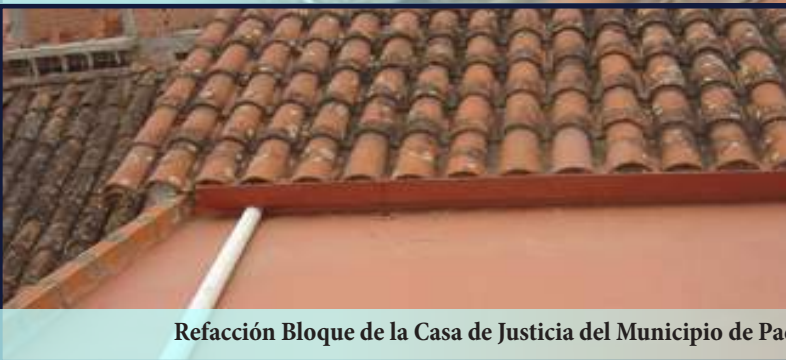
Reparación de cubierta
