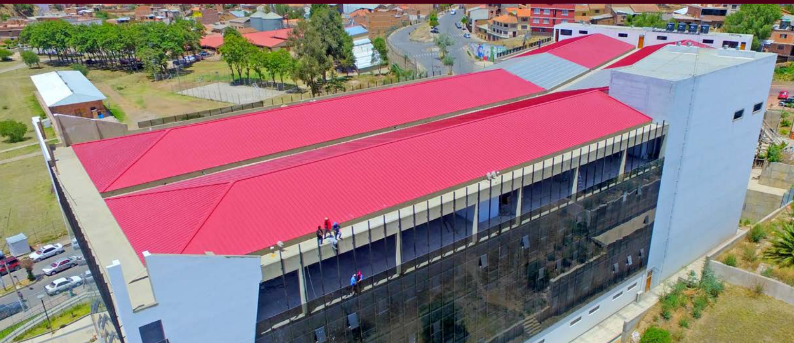
Construcción de cuarto piso del Tribunal Departamental de Justicia de Chuquisaca a cargo de la DAF Nacional
