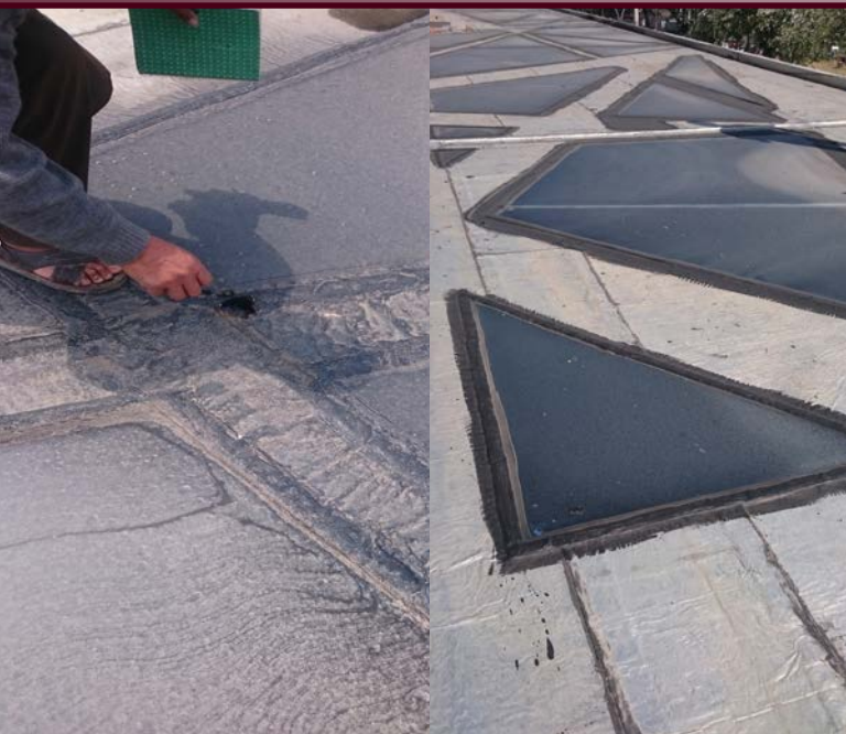
Refacción de cubierta de oficinas de la DAF
