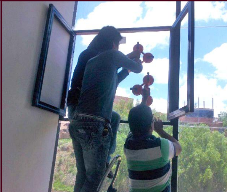
Apertura de Ventana en el 2do y 3er piso del TDJCH
