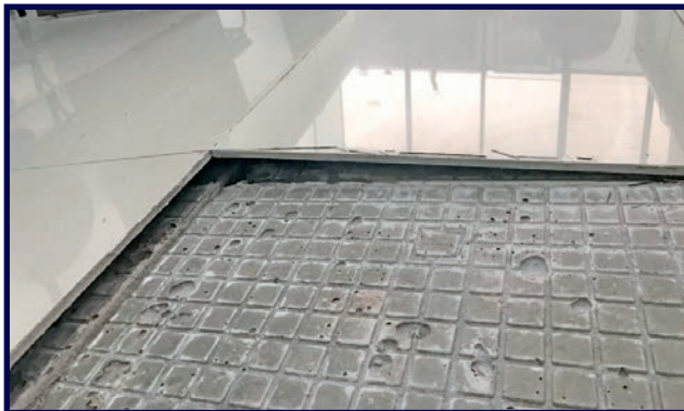
Reposición y colocados de porcelanato en 2° y 3° piso del TDJ
