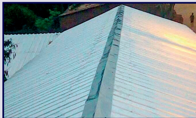
Refacción y Mantenimiento (Cambio de Cubierta de calamina) de la Casa de Justicia de Huacareta
